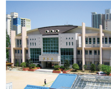
| 부산 원예고등학교 다목적강당 증축공사
