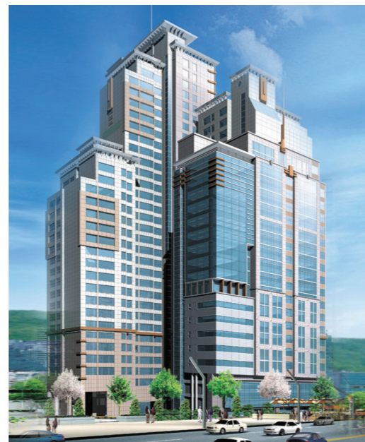
1 대연동 일동 지에인 주상복합 아파트 착공 2003.09 준공 2006.10 세대수 231세대
