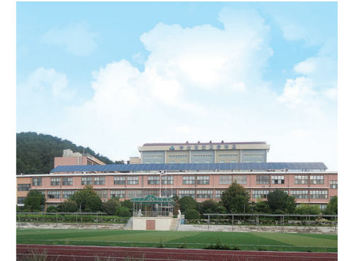
| 부산 장안종합고등학교 증축공사
