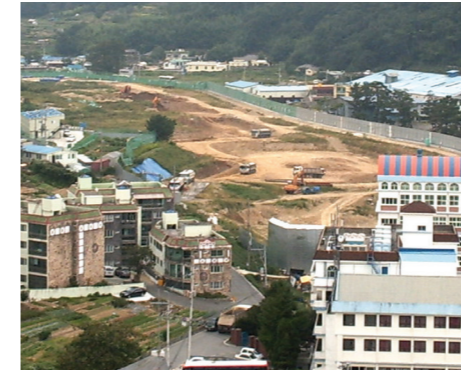
| 양산 교동 부지 조성공사
