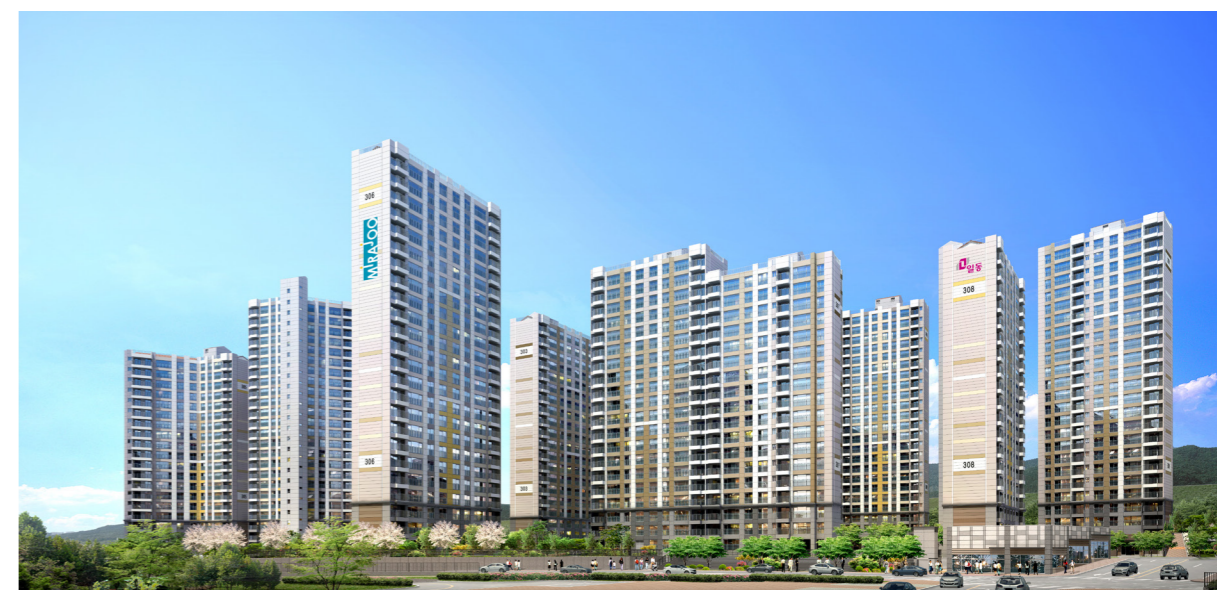
울산매곡 중산지구 U-스타시티 일동 미라주 더 스타 (3단지) 착공 2016.12 준공 2019.07 세대수 411세대
